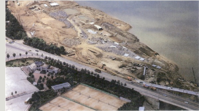
(그림 II-227) 한강종합개발 제5공구(반포) 건설 공사 현장. / 출처 : 서울시.
