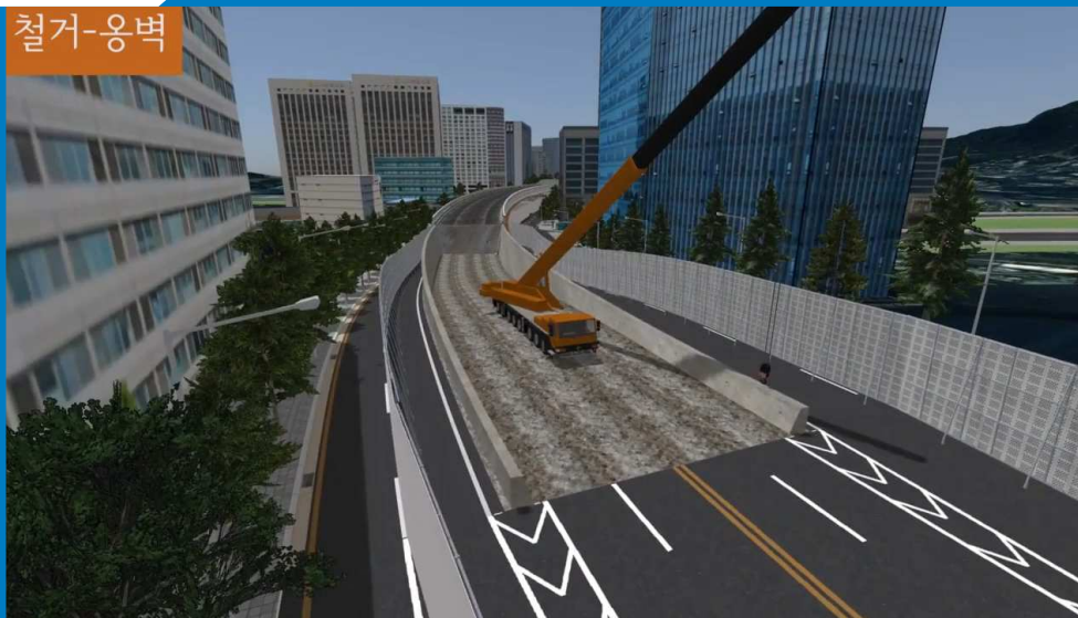
Снос путепровода Сосомун
